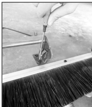
Рис. 2 Установка крепежной планки
