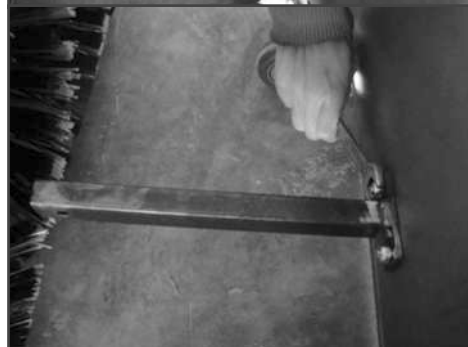
Рис. 2 Установка кронштейнов крепления отвала
